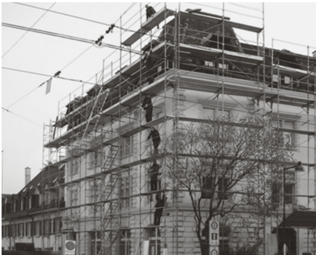
Die Birsbrugg wird «ingerüstet» um das Dach zu erneuern
